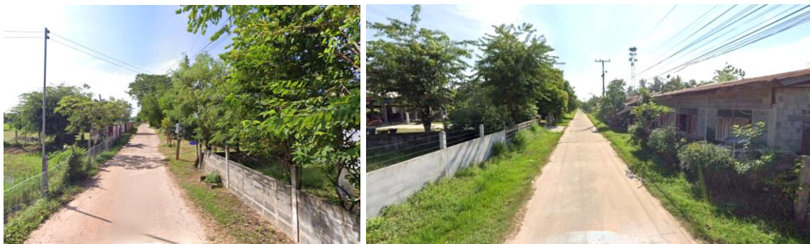
รูปภาพที่ 19 : ถนนคอนกรีตเสริมเหล็ก (คสล.) ภายในหมู่บ้านแมต
